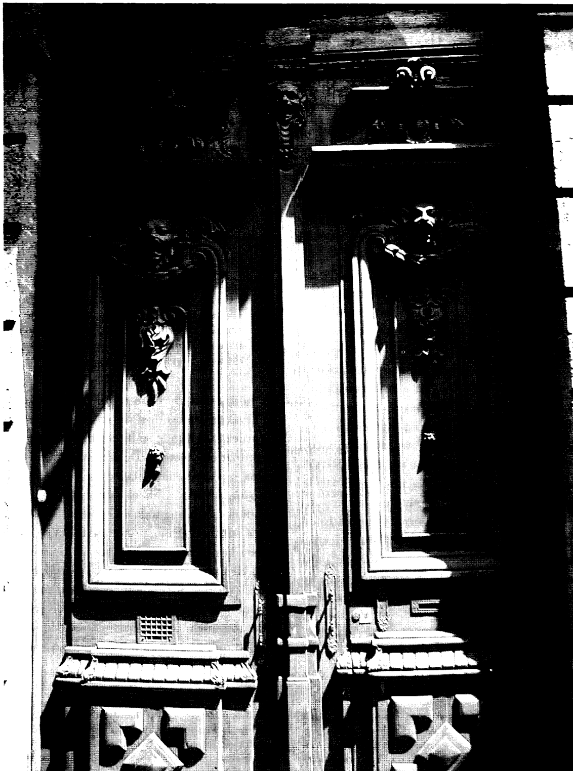
Detalle de la puerta de acceso a la mansión ubicada en Hamburgo 8, colonia Juárez.
